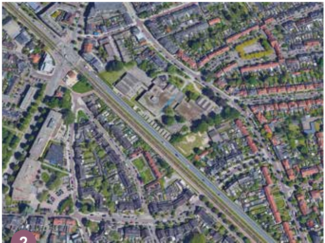
2 Miereveldstraat Courtyard , 1921 Architecture: W.K. de Wijs in collaboration with M.J. Klijnstra, H.A. Pothoven and G. van Hoogevest
