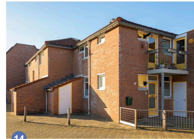
14 Kantemars housing complex (1984-85) Huijgenserf 22-60, Hoevelaken Jan Verhoeven
