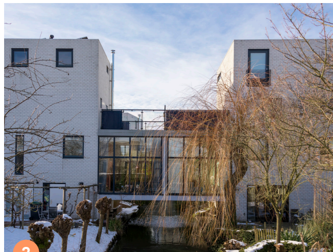
2 Bridge houses Kattenbroek (1994) Bruggensingel-Zuid, Bruggensingel-Noord, Kattenbroek, Amersfoort Leo Heijdenrijk
