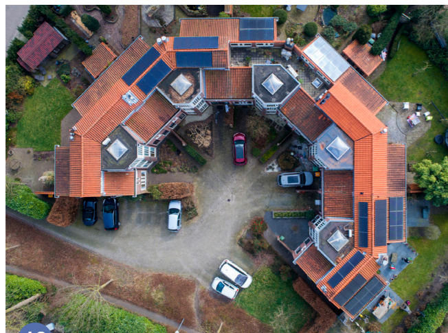
18 Residential houses Bijenvlucht (1974-77) Bijenvlucht/Horstpad, Hoevelaken Jan Verhoeven
